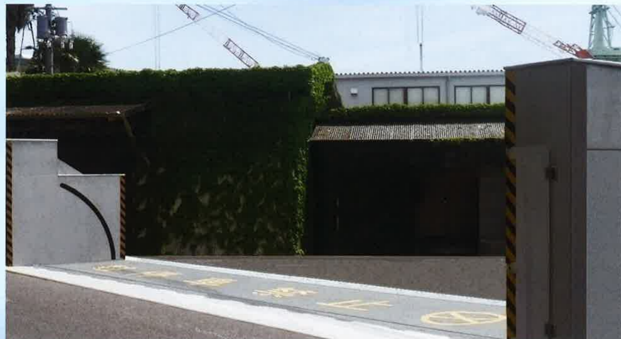
施工例：徳島県里浦地区陸閘ゲート設備
