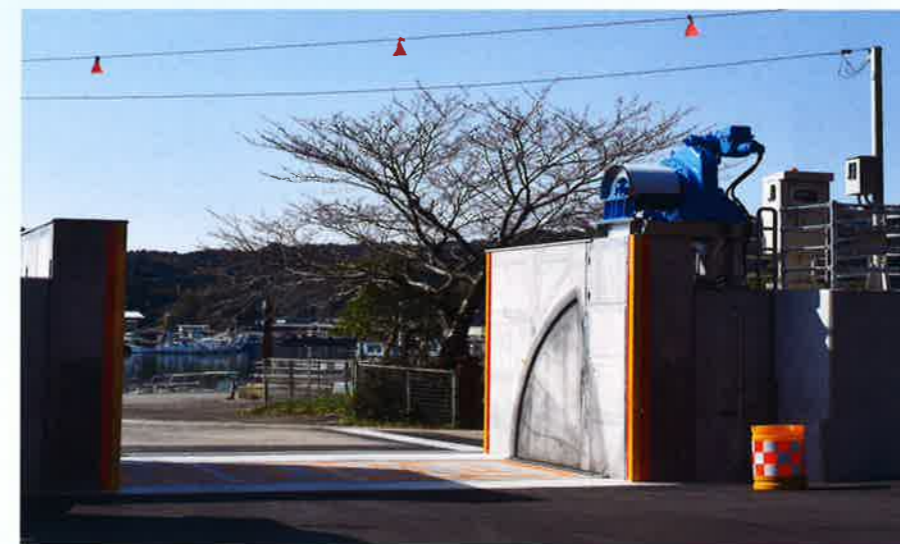
施工例：徳島県浅川地区 自動閉鎖陸閘ゲート
